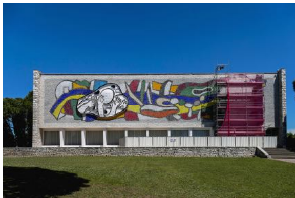
Musée national Fernand Léger, 2015 La façade du musée en cours de restauration
