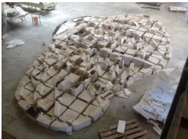
Restauration de la façade Reconstitution de la céramique en atelier, avant restauration
